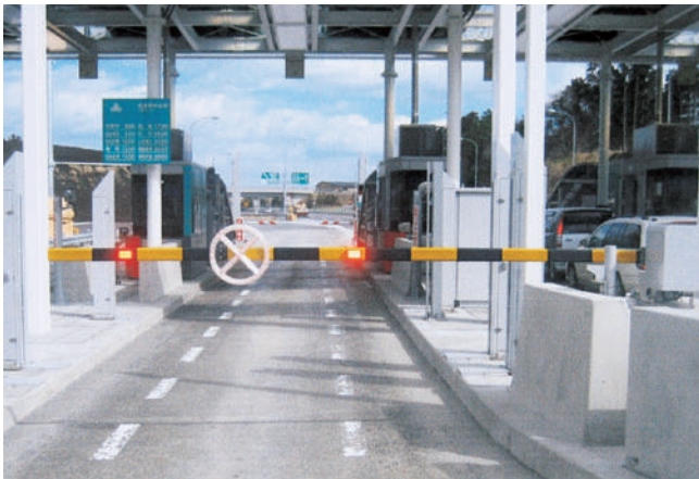
交通遮断機 ゲートマン
