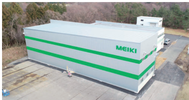
一関第2大型工場（岩手県）2022年1月稼働
